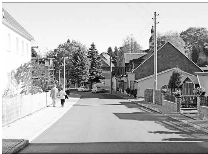
Ausbau Elterleiner Straße in Schlettau
