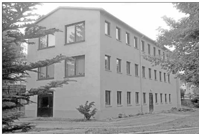
Modernisierung der Grundschule in Schlettau
