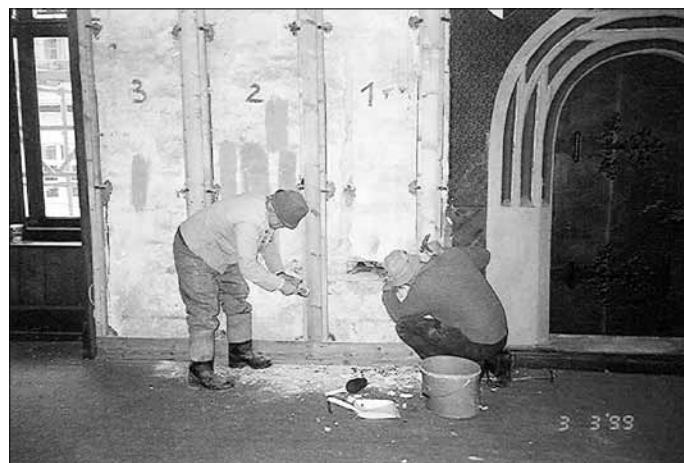
Zur Bekämpfung des Hausschwammes musste die Täfelung des Rittersaals abgenommen und kunstgerecht wieder angebracht werden.
