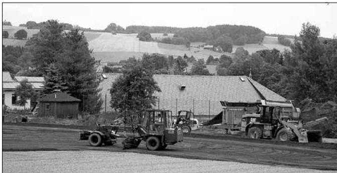
Für eine dauerhafte Nutzung des Rasenplatzes war die Installation einer funktionstüchtigen Ent- und Bewässerung dringend erforderlich. Hierzu waren die Herstellung einer Drainage, das Verlegen von Saugerleitungen und das Ableiten in eine Sammlerleitung erforderlich. Alle diese Arbeiten und auch die Installation der vollautomatischen Bewässerungsanlage wurden von unseren Fußballern in Eigenregie ausgeführt.
