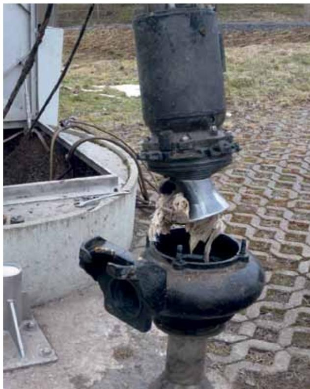
Foto 3: Verzopfungen an Zulaufpumpe
