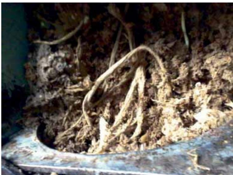
Foto 1: Rückstände in Zulaufleitung zur Kläranlage
