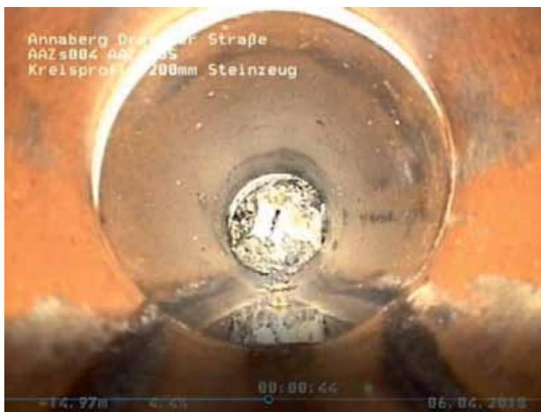
Foto 2: Aufnahme durch Kanal-TV-Kamera – Totalverschluss durch Feuchttücher im Kanal im Ortsnetz Annaberg
