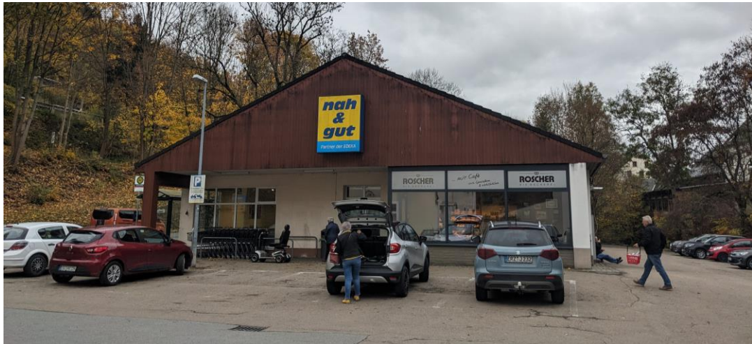
Abbildung 15: nah & gut-Supermarkt am NVS Talstraße in Annaberg-Buchholz
