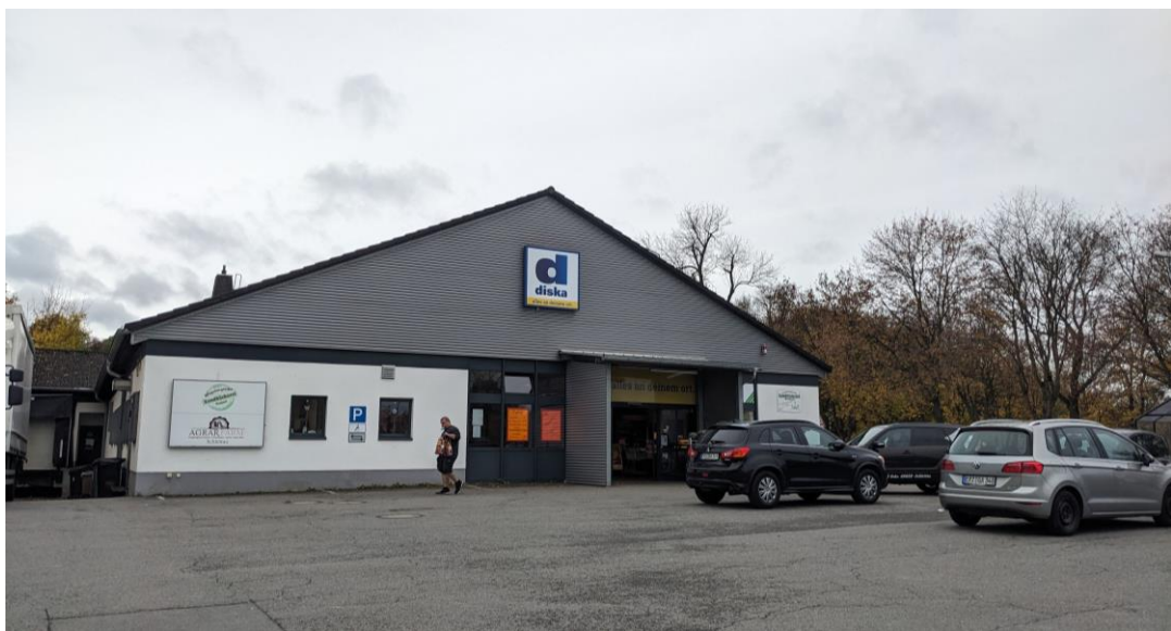
Abbildung 2: Blick auf den Diska-Lebensmitteldiscounter am Vorhabenstandort
